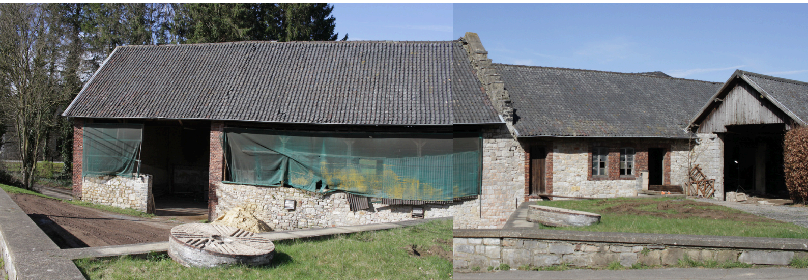
Die „Alte Mühle“ vor der Sanierung
