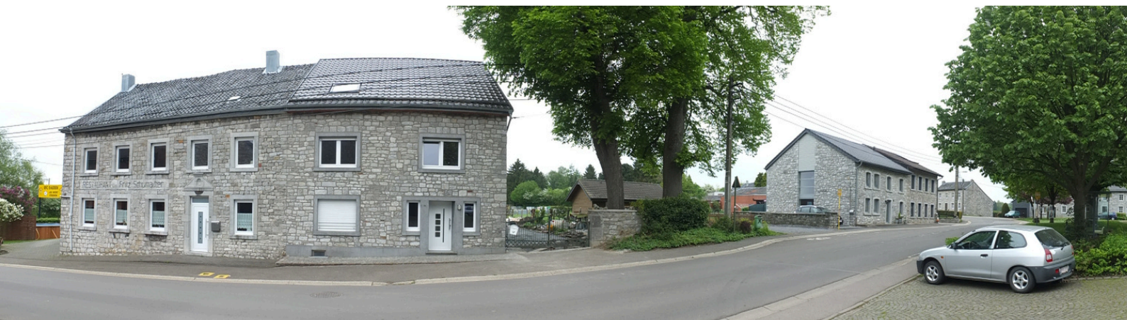
Situation vor den Arbeiten
