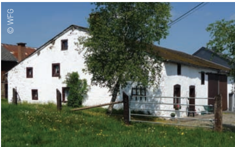
Ein schönes Beispiel eines Breitgiebelhauses
