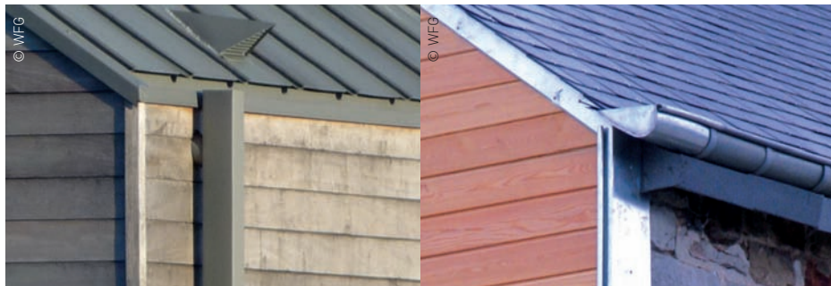
Moderne, leicht wirkende Ausführung des Ortgangs und der Traufe ohne Dachüberstand
