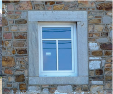
... aber zu schmale Ausführung der T-Unterteilung
