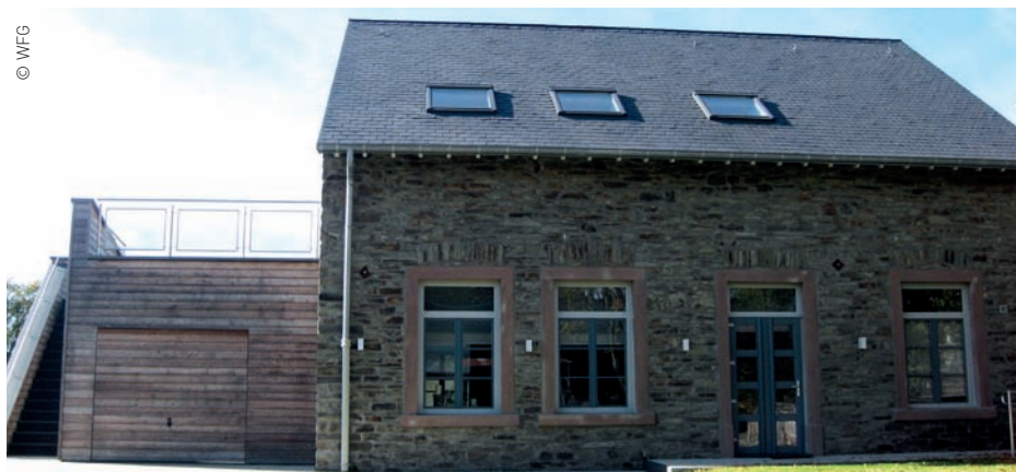
Gleichmäßige, unauffällige Reihung der Dachflächenfenster
