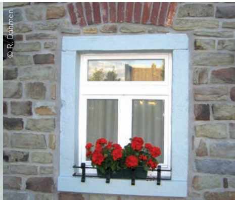
Neues T-Fenster mit einer überbreiten und flächenbündigen T-Aufteilung. Die Verglasung des Oberlichtes wird dadurch zu schmal
