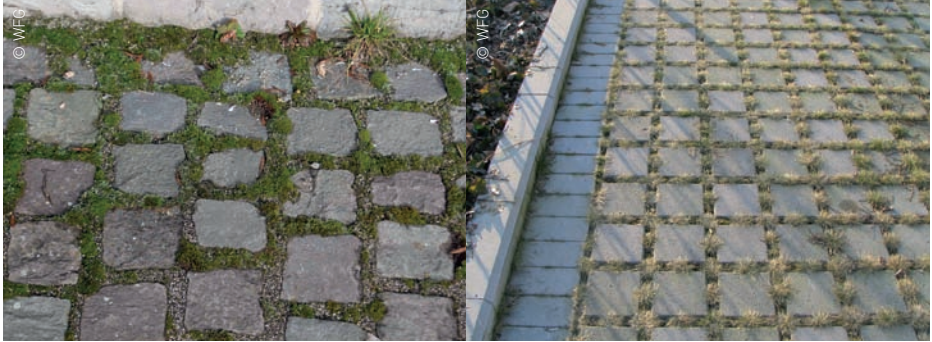
Pflasterung mit grüner Fuge
