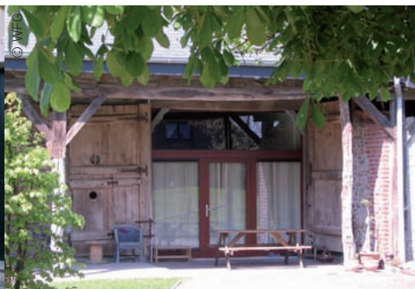
Die alten Holzschläge des Scheunentores bleiben erhalten und werden durch eine moderne Verglasung ergänzt
