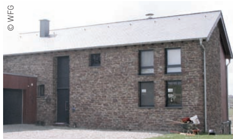
Modernes Mauerwerk, das sich durch Farbe und Art der Vermauerung an das traditionelle Mauerwerk anlehnt
