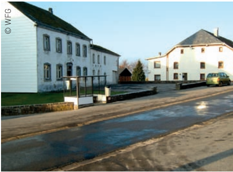
Große versiegelte Flächen, die den Straßenraum prägen
