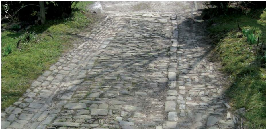
Erhalt einer alten Natursteinpflasterung
