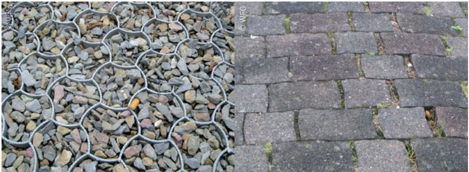
Kunststoffrasengitter mit Schotter gefüllt
