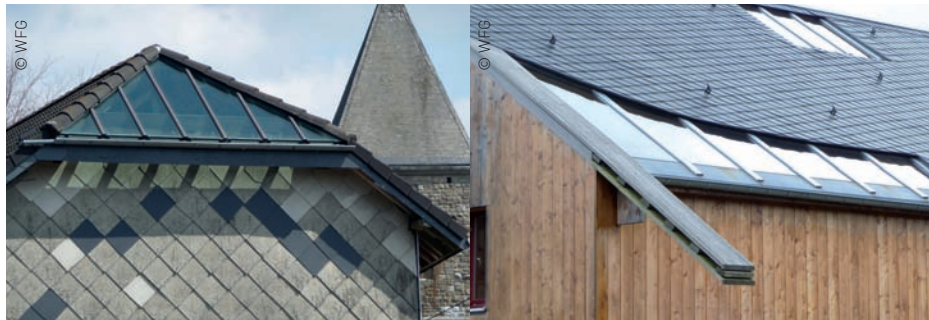
Die Verglasung des Krüppelwalms oder eines Teils der Dachfläche in das Gebäude integriert
