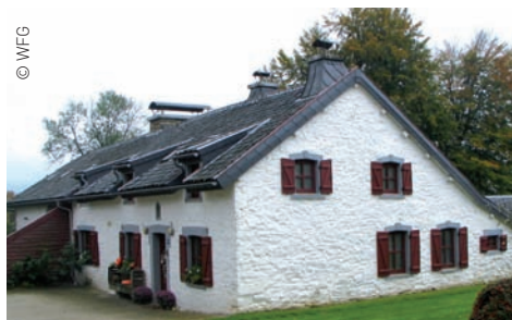
Historische Schleppgauben, die sich einfügen
