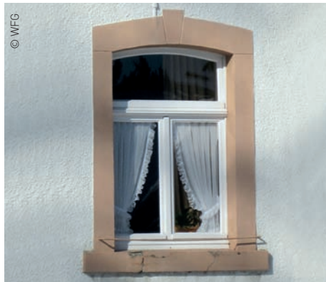
Neues T-Fenster aus Holz mit guten Proportionen. Auch die feine Profilierung ist sehr gut ausgeführt
