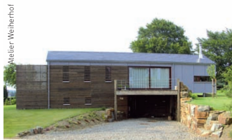
Moderne Gebäude ohne Dachüberstand
