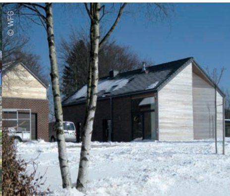
Die Fassade wird durch das Material gegliedert
