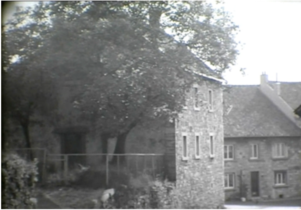
Abriss „Haus Ostländer“, Kreuzung Burgstraße / Grachtstraße (Ausschnitte aus dem Film von Herbert und historisches Foto)
