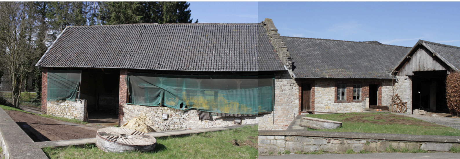
Die „Alte Mühle“ vor der Sanierung
