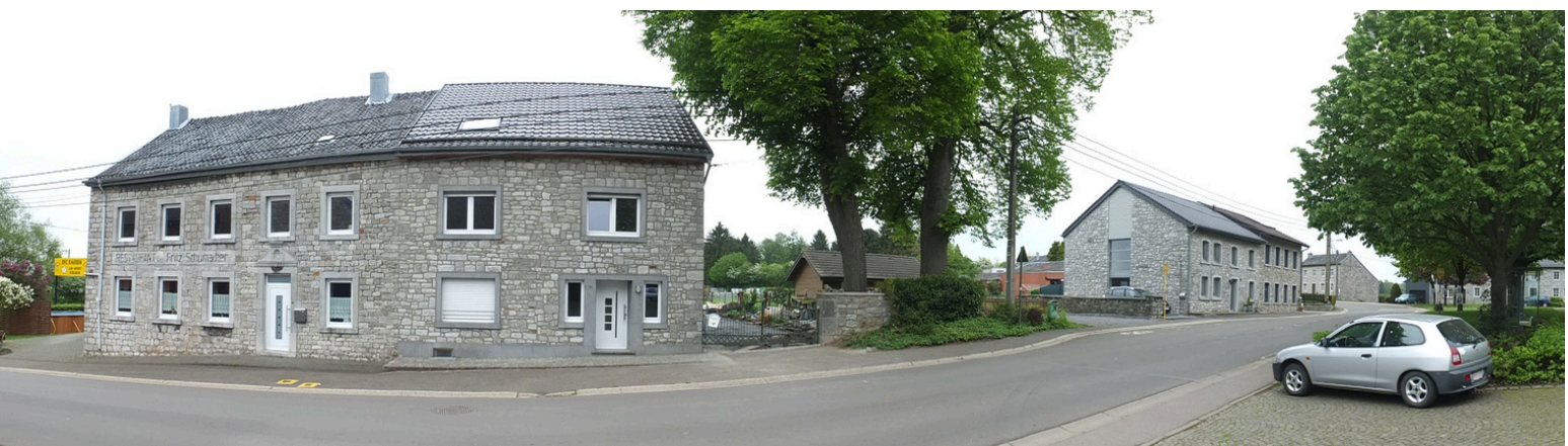
Situation vor den Arbeiten
